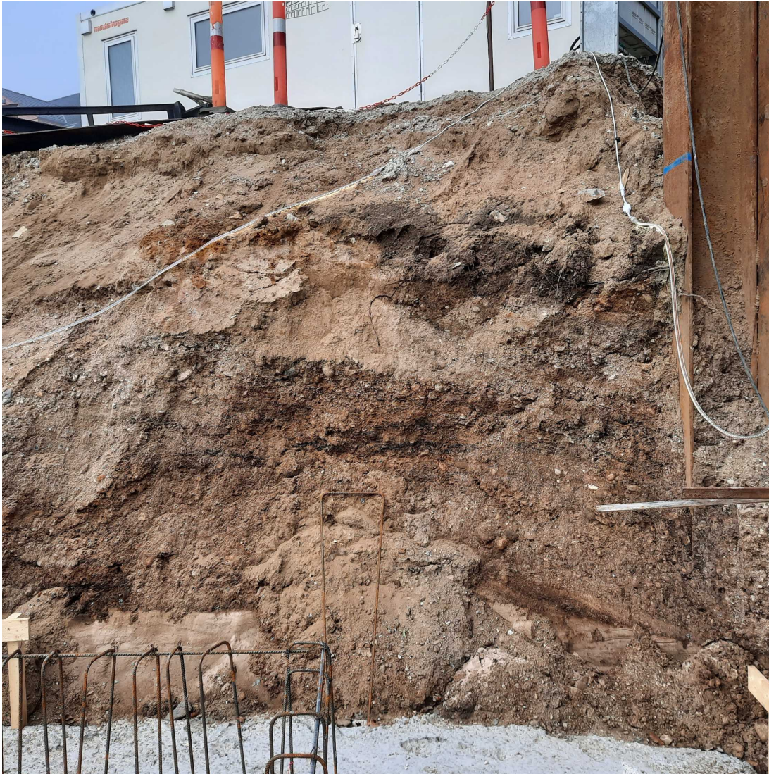
Billedet viser hjørnet af udgravningen, hvor el-tavlen står øverst til højre, hvor jorden ikke er effektiv sikret imod jordskred.
