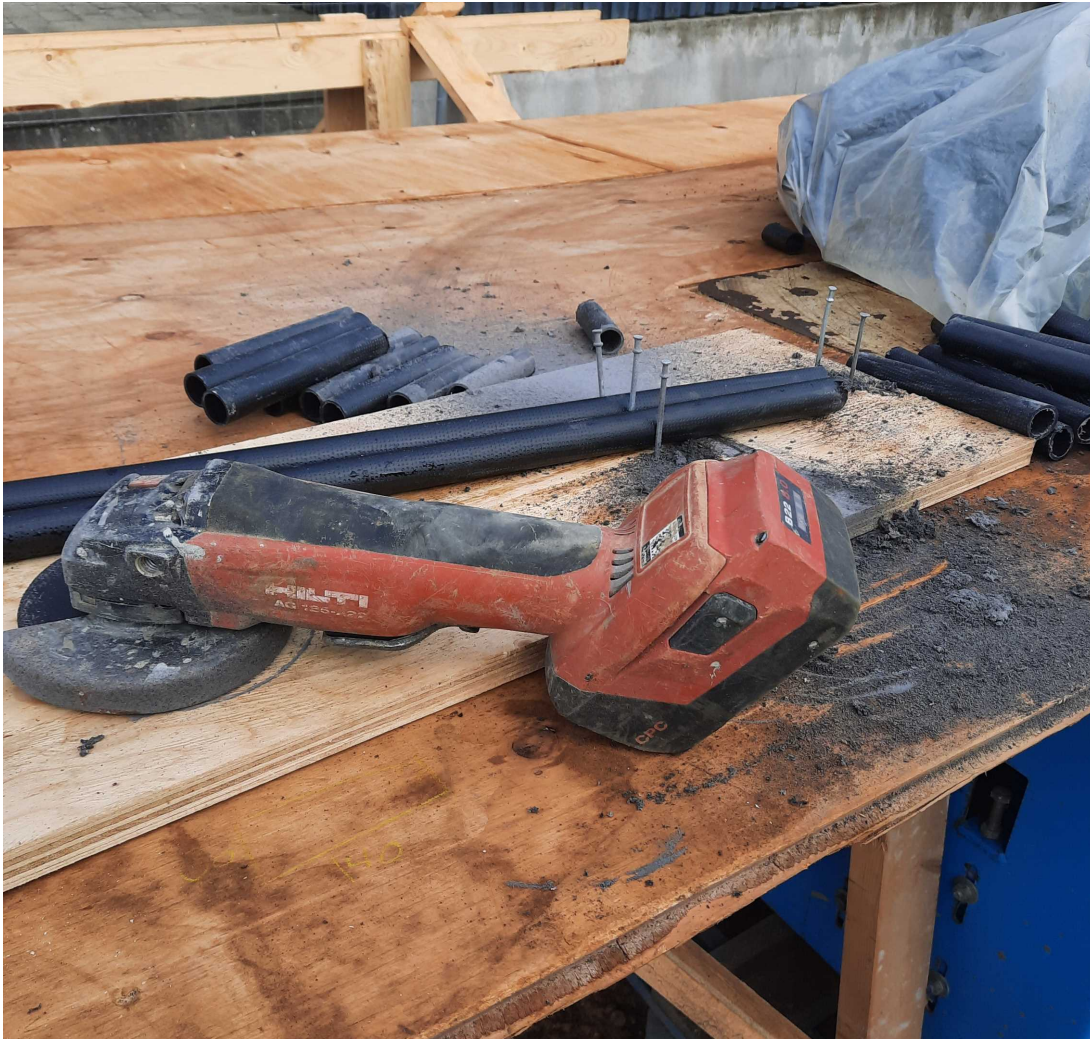
Billedet viser vinkelsliberen og arbejdsbordet, hvor den ansatte skar stålrør.
